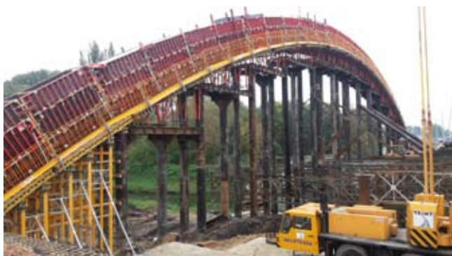
Budowa mostu nad Bystrzycą
