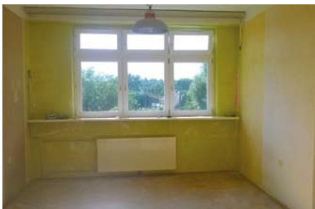
Widok pomieszczenia w trakcie remontu
