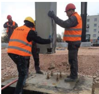
Montaż słupa – budowa parkingu w Kielcach
