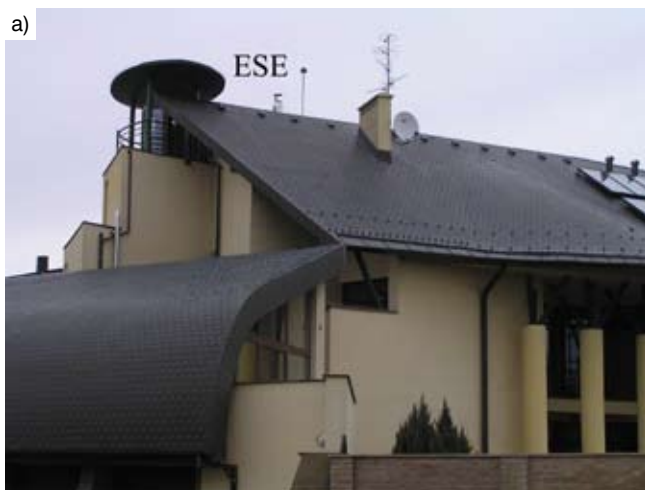
Rys. 8. Zwód ESE na budynku mieszkalnym we Wrocławiu
