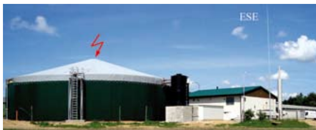
Rys. 6. Stacja biogazu w Malsicach w Czechach. Miejsce uderzenia pioruna zaznaczono czerwoną błyskawicą, napis ESE wskazuje położenie maszty z głowicą aktywną [12]
