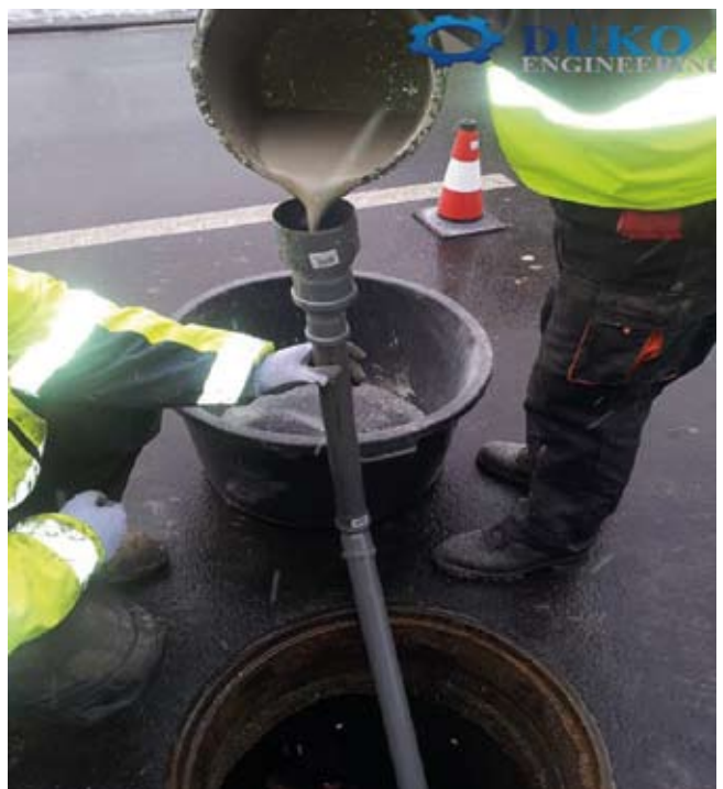
Rys. 2. Wypełnienie przestrzeni pomiędzy starą studnią a panelem żywiczną masą iniekcyjną
