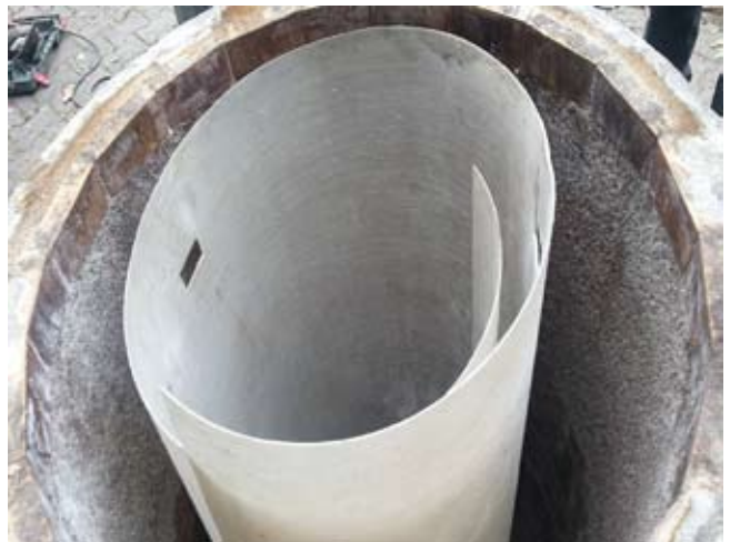
Rys. 1. Wkład panelowy przygotowany do zamontowania w studni
