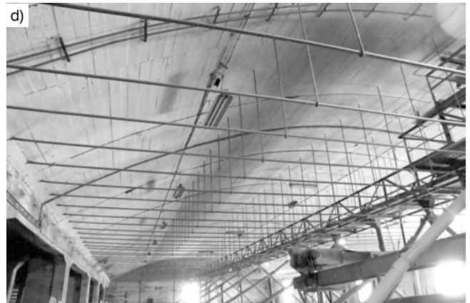
Rys. 7. Konstrukcja nawy: a) kratownicowa, stalowa cementowni Silesia (nawa główna), b) żelbetowa, łukowa z dachem dwuspadowym cementowni Wróblin (nawa główna), c) kratownicowa, stalowa cementowni Silesia (nawa boczna), d) żelbetowa łukowa z podwieszonymi ściągami cementowni Wróblin (nawa boczna)
