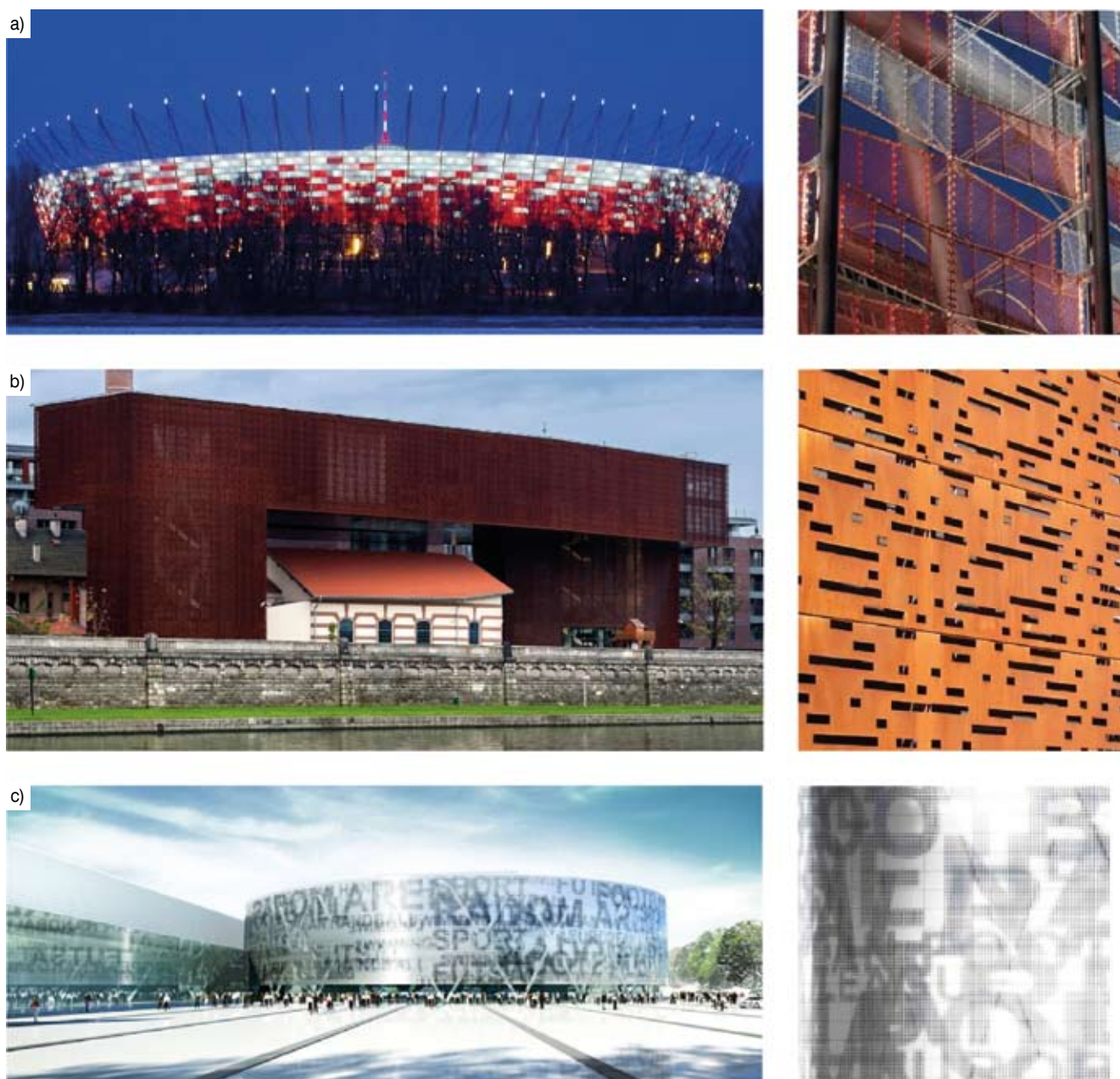
Rys. 1. Przykłady obiektów z elewacją wykonaną z perforowanych elementów okładzinowych: a) Stadion Narodowy w Warszawie, b) Ośrodek Dokumentacji Sztuki Tadeusza Kantora „Crikoteka” w Krakowie, c) hala widowiskowo-sportowa w Radomiu (w trakcie realizacji) [7]
