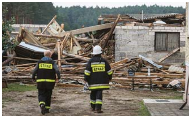
Rys. 8. Zniszczenia po przejściu wiatrów huraganowych (źródło: internet)
