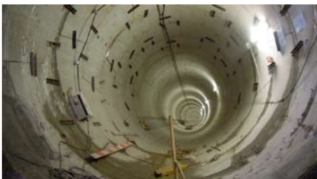
Rys. 6. Widoczne pierścienie tunelu metra
