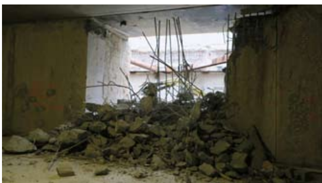
Rys. 4. Przebicie przez ścianę szczelinową do stacji (wejście W3)
