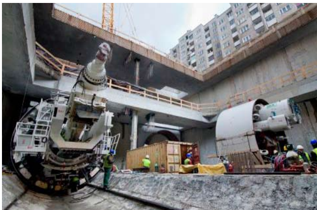
Rys. 2. Rozpoczęcie drążenia tuneli przez tarcze TBM (źródło: www.metro.waw.pl )
