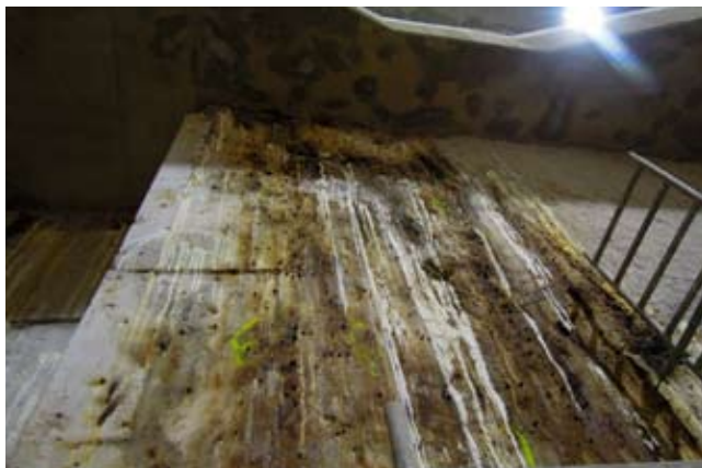
Rys. 3. Uszczelnienia ściany szczelinowej na stacji C17
