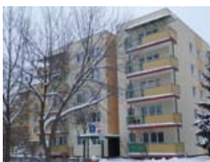
Rys. 9. Widok budynku po ociepleniu [3]
