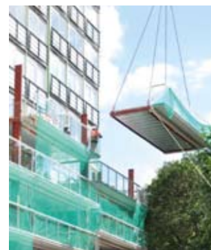
Rys. 4. Widok sposobu montażu dostawianego segmentu podczas realizacji modernizacji [1-3]
