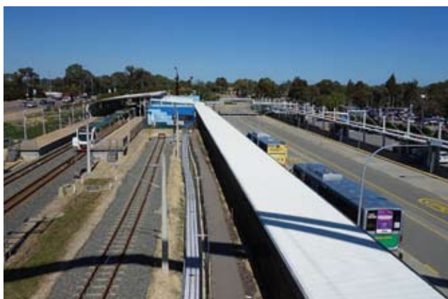
Rys. 6. Widok ogólny kompleksu komunikacyjnego w Mandurah (Australia, fot. A. Wysokowski)
