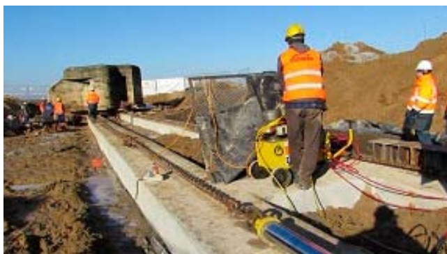
Rys. 7. Tor nasuwczy
