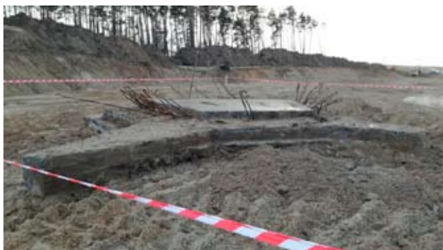
Rys. 5. Fundament tradytora dwustronnego
