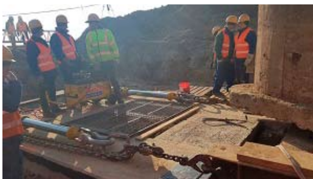
Rys. 8. Ruszt stalowy na podkładkach ślizgowych
