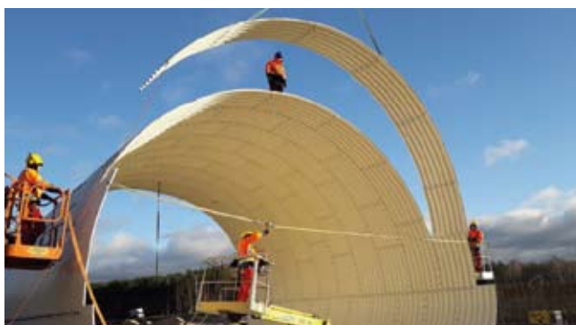
Rys. 10. Montaż elementów przejścia
