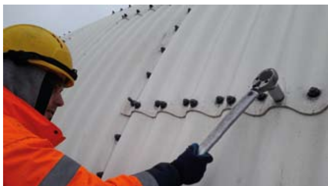
Rys. 11. Dokręcanie śrub
