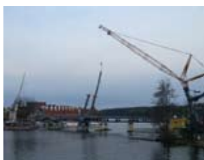
Rys. 10. Montaż nowego pylonu
