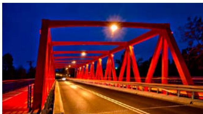
Rys. 1. Widok mostu w ciągu ulicy Spornej w Bydgoszczy
