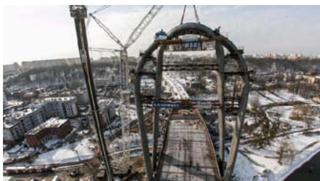
Rys. 6. Widok ogólny konstrukcji mostu
