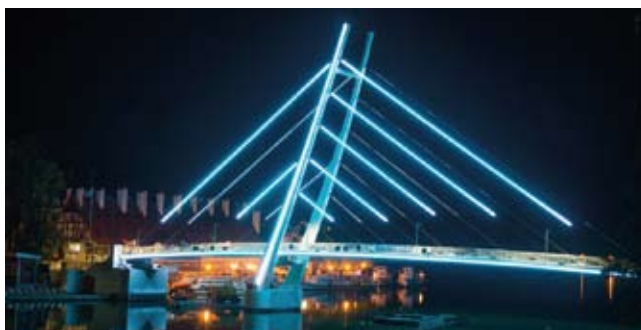
Rys. 9. Iluminacja wykonanej kładki
