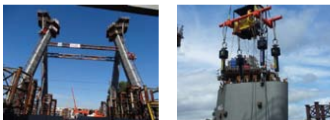
Rys. 7. Po lewej: tymczasowe stężenia kratowe; po prawej: system wspomagania pozycjonowania SynHoist firmy Enerpac
