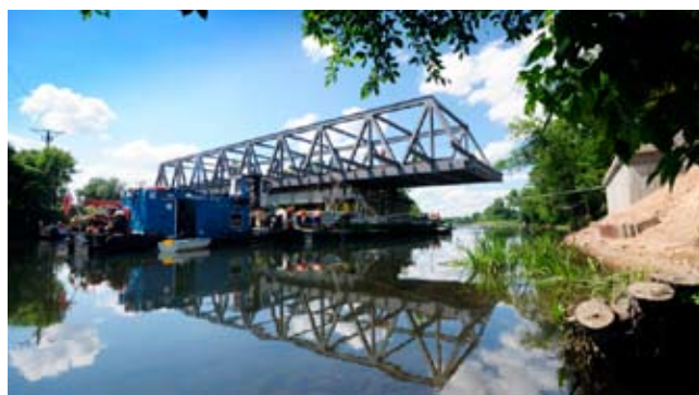
Rys. 3. Montaż konstrukcji poprzez nasuwanie
