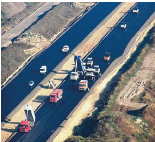
Rys. 1. Układanie podbudowy zasadniczej na odcinku A
