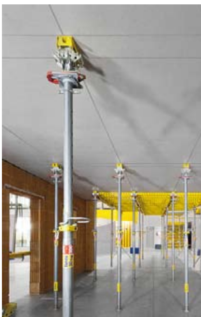
Odcisk betonu ze sklejki Xlife przy użyciu systemu panelowego Dokadek z głowicą opadową XF
