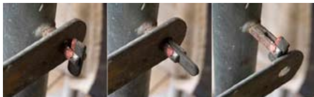
Rys. 2. Łatwe w demontażu zamocowanie balustrady rusztowania [8]
