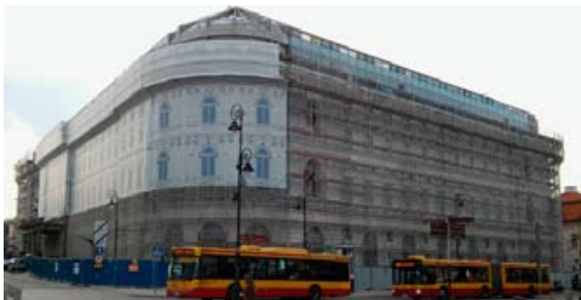
Rys. 3. Nietypowe rusztowanie fasadowe obiektu w centrum miasta z siatką ochronną (fot. autorek)
