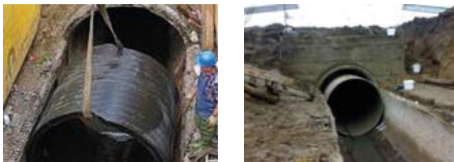
Rys. 21. Montaż poszczególnych modułów w komorze roboczej [16]
