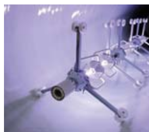
Rys. 12. Utwardzanie rękawa za pomocą lamp UV [20]
