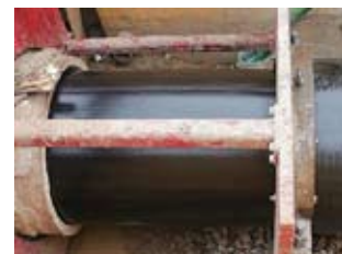
Rys. 18. Wprowadzanie wraz ze zmniejszeniem średnicy nowego rurociągu PE do rurociągu poddawane renowacji [20]
