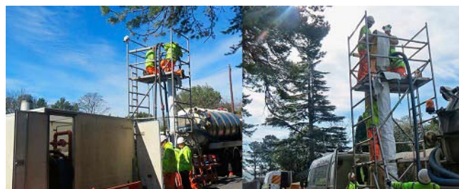
Rys. 14. Wieże służące do wprowadzania rękawa do rurociągu poprzez napełnianie go wodą [20]
