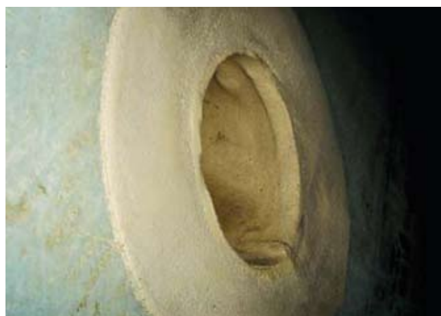
Rys. 30. Profil kapeluszowy po utwardzeniu – widok od strony kanału głównego [20]
