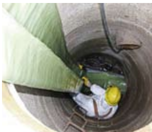
Rys. 8. Wprowadzenie rękawa do kanału poprzez studzienkę kanalizacyjną [10]
