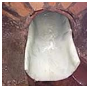
Rys. 10. Rękaw nasączony żywicą po wprowadzeniu do kanału przed rozprężeniem [20]
