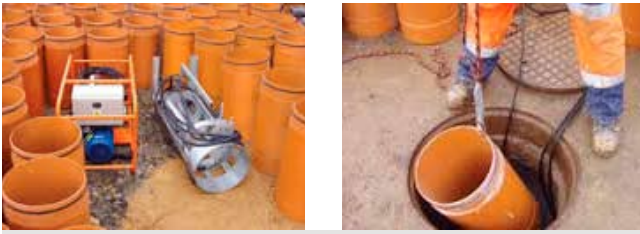
Rys. 23. Po lewej: moduły rurowe wraz z zestawem montażowym; po prawej: montaż modułu poprzez właz kanalizacyjny [17]
