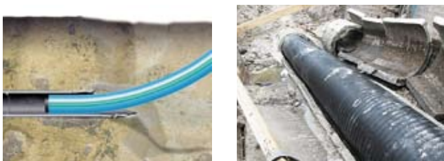
Rys. 19. Instalacja nowego rurociągu z PE poprzez wciągnięcie do rurociągu poddawanego renowacji [20]
