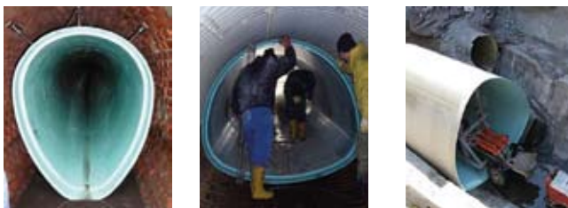
Rys. 22. Relining krótki kanałów o przekrojach niekołowych [15]
