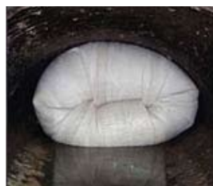
Rys. 13. Inwersyjny montaż rękawa w rurociągu [20]
