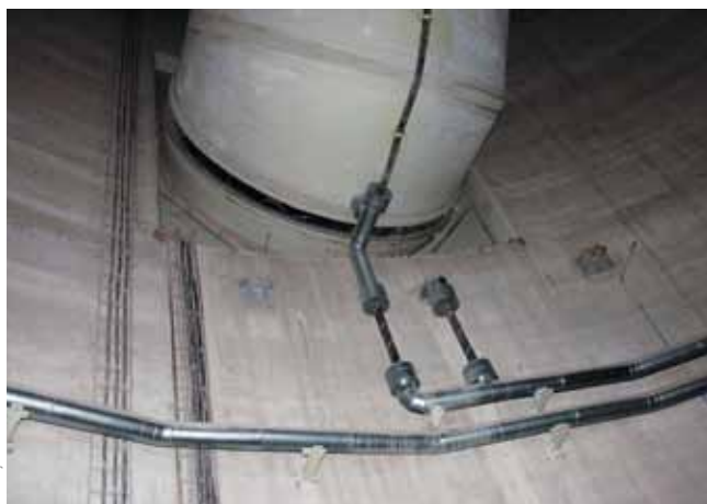
Rys. 6. Instalacja odprowadzania kondensatu spalin z dolnej części przewodu spalin
