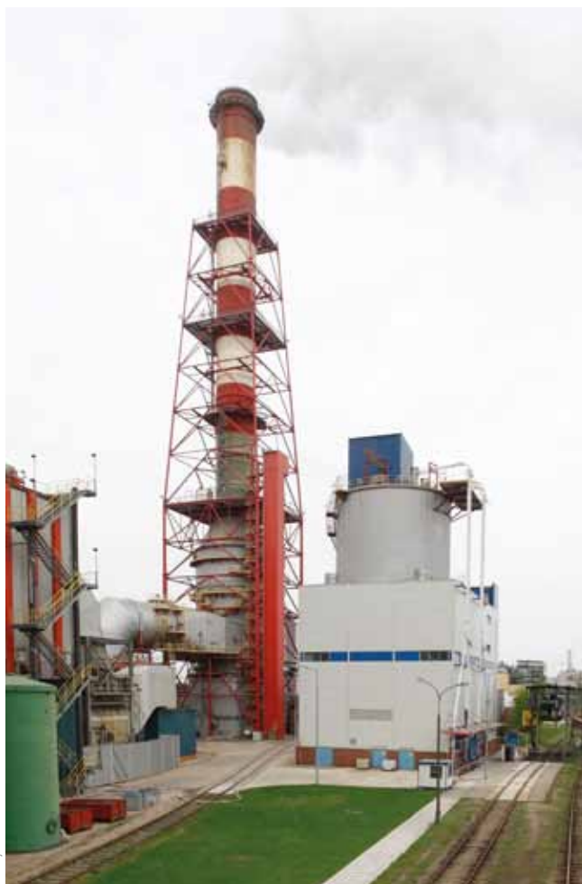
Rys. 2. Komin jedнопrzewodowy z TWS posadowiony na absorberze
