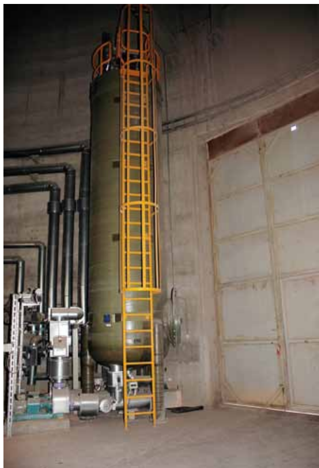
Rys. 7. Zbiornik kondensatu spalin w kominie
