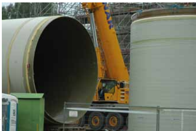
Rys. 5. Prefabrykowane segmenty przewodów spalin z TWS przygotowane do montażu wewnątrz kominu wieloprzewodowego
