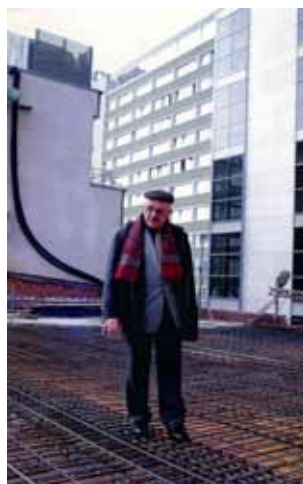
Rozbudowa budynku PASTA
