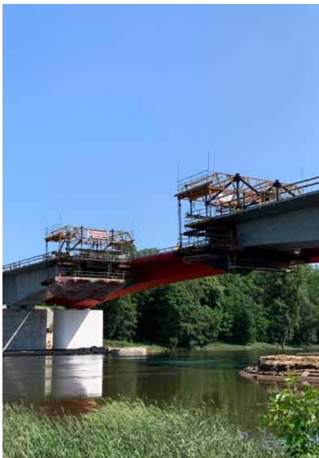
Wózki nawisowe na budowie mostu MS-4B w ciągu drogi S3
