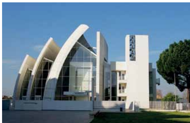
Rys. 12. Kościół milenijny Dives in Misericordia w Rzymie wykonany z białego betonu fotokatalitycznego [16]
