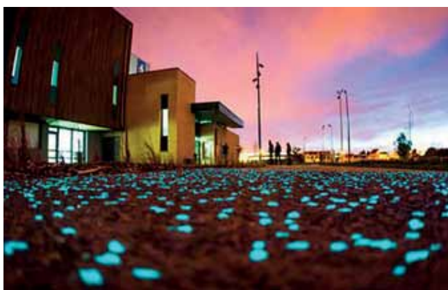
Rys. 24. Plac przed halą sportową w Harnes oświetlony nawierzchnią betonową z kruszywem luminescencyjnym [26]
