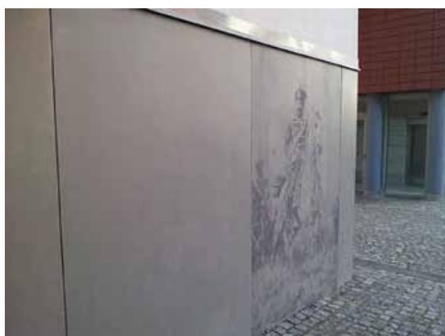
Rys. 8. Betonowa płyta prefabrykowana na bazie matrycy, Hossa Garnizon, Trójmiasto [7]
