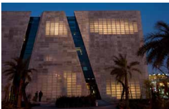
Rys. 16. Panele i.light wbudowane w elewację włoskiego pawilonu na World Expo 2010 w Szanghaju [20]
