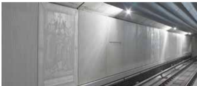
Rys. 5. Stacja metra z panelami z fotobetonu, Norymberga, Niemcy [7]
