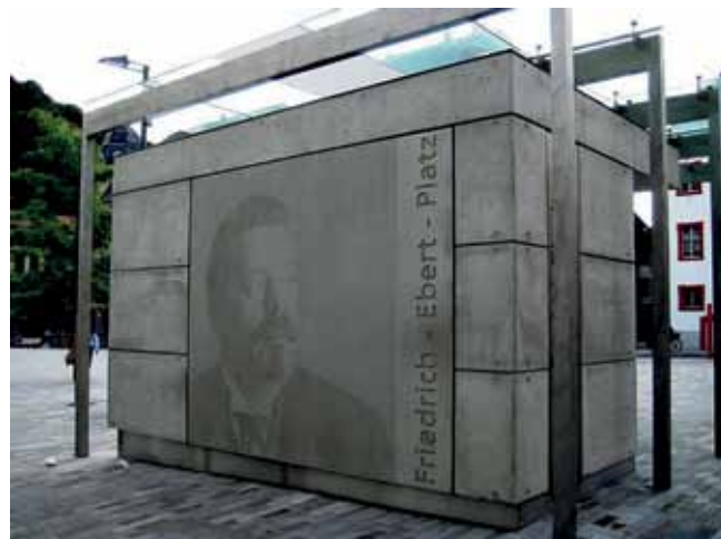
Rys. 6. Prefabrykowana płyta z fotobetonu na placu Freidricha Eberta, Heidelberg [7]
