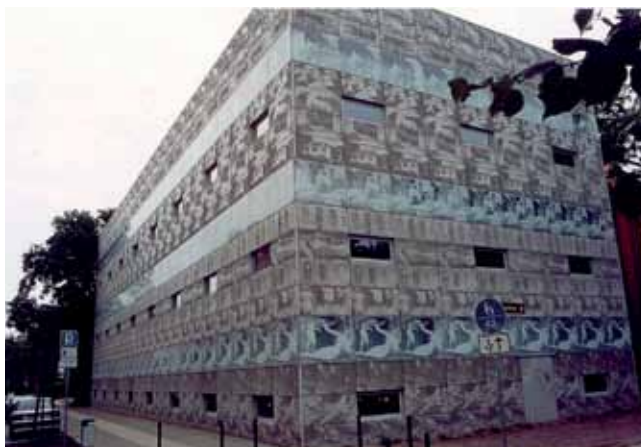
Rys. 1. Fotobeton na elewacji biblioteki Wyższej Szkoły Technicznej w Eberswalde; źródło: fotografia własna
