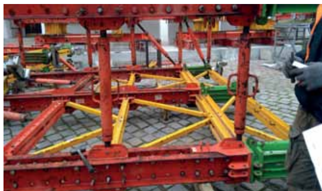
Rys. 2 i 3. Wieże VST z pozycji montażowej. Widok segmentu głowicowego
