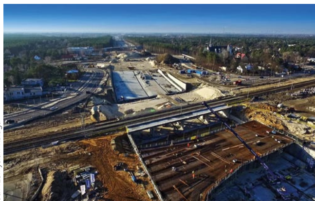
Widok na obiekty Węzła Patriotów – widoczny obiekt WD 05-06 (na pierwszym planie) i WK 05-05 (wiadukty kolejowe)
