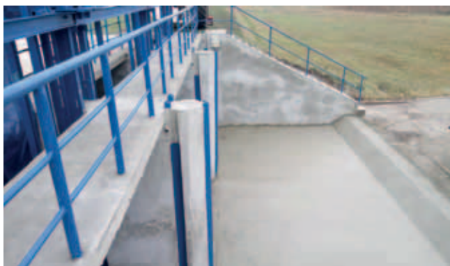
Rys. 1. Jaz wyremontowany przy użyciu zaprawy mineralnej REBET A
