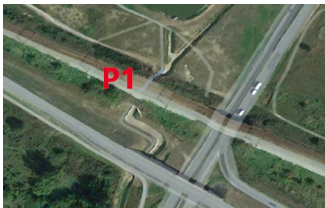
Rys. 2. Ogólny widok usytuowania obiektu inżynierskiego P1
