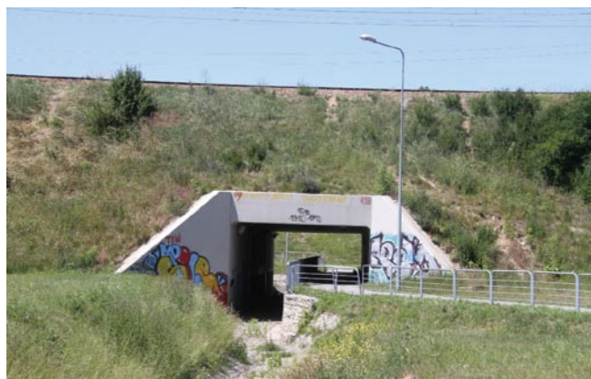
Rys. 1. Widok zrealizowanego przejścia pod torami
