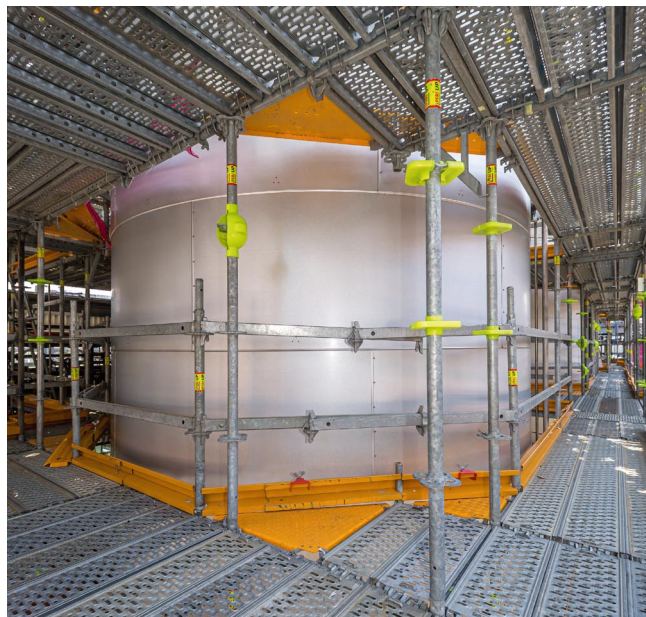
Rys. 8. Rozwiązanie naroży i podestów bez szczelin i uskoków z wykorzystaniem elementów systemu PERI UP zapewniły bezpieczne użytkowanie rusztowania. Nasadki ochronne w kolorze sygnalizacyjnym dodatkowo wzmocniły bezpieczeństwo
