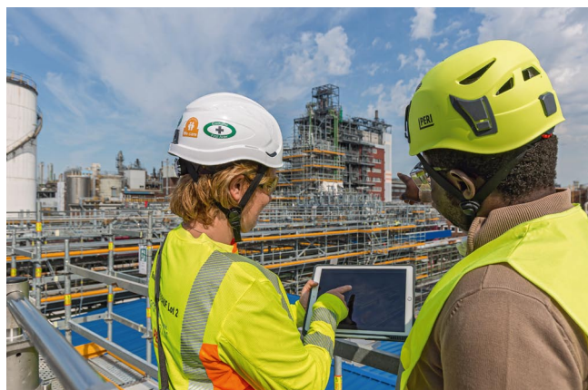
Rys. 1. Najnowocześniejsze planowanie rusztowań z wykorzystaniem technologii BIM i innowacyjnych systemów PERI odegrały kluczową rolę w budowie nowego kompleksu witaminy A w BASF SE w Ludwigshafen w Niemczech
