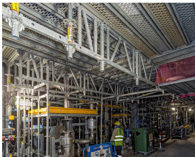
Rys. 9. W przypadku gdy do przewieszenia użyto modułowego dźwigara systemowego ULS Flex, podesty można było zainstalować bezpośrednio na górnych pasach dźwigara kratowego, co oznacza, że kierunek podestów można zmienić w dowolnym momencie
