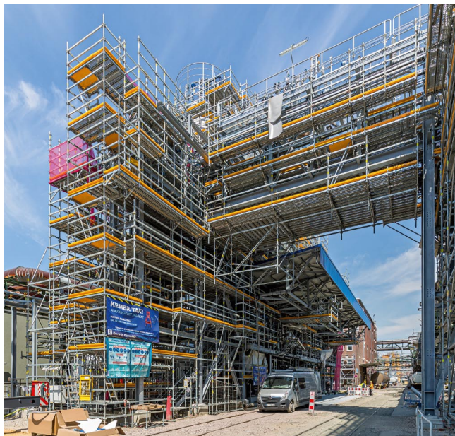
Rys. 6. Większość z około 4000 elementów rusztowań została zaplanowana przy użyciu CAD i dostarczona jako modele 3D w ciągu 18-miesięcznego okresu realizacji projektu wymaganego do budowy złożonego zakładu BASF. W ten sposób możliwe było zminimalizowanie kosztów rusztowań i wdrożenie wysokich standardów bezpieczeństwa już na etapie planowania
