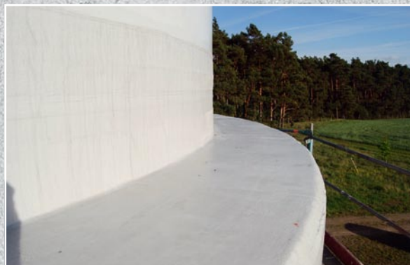
Wykonana izolacja fundamentu betonowego i połączenia fundamentu z płaszczem elektrowni wiatrowej
