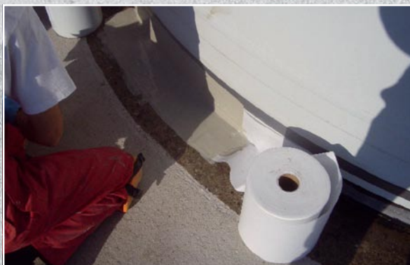
Wklejanie flizeliny wzmacniającej izolację – WeVlies
