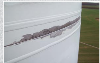
Oczyszczone podłoże
