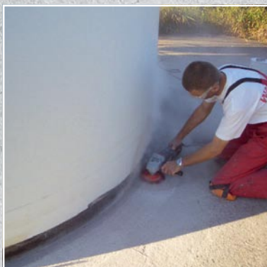
Przygotowanie podłoża przez szlifowanie
