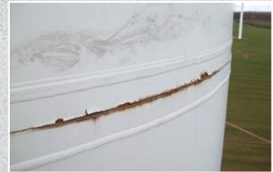
Stan istniejący - widoczna korozja
