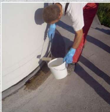
Gruntowanie podłoża betonowego – Wecryl 176
