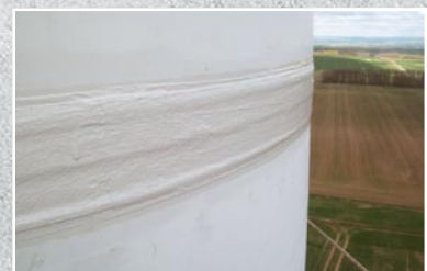
Widok uszczelnionego połączenia segmentów płaszcza stalowego elektrowni wiatrowej
