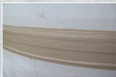
Uszczelnienie z elastycznej żywicy Wecryl R 230 thix z wklejoną flizeliną WeVies
