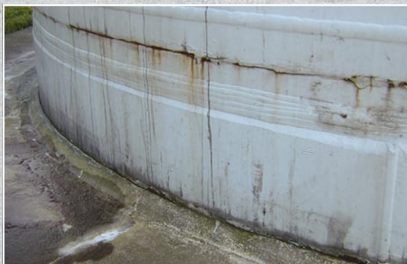
Degradacja betonu fundamentu i płaszcza stalowego wieży elektrowni wiatrowej
