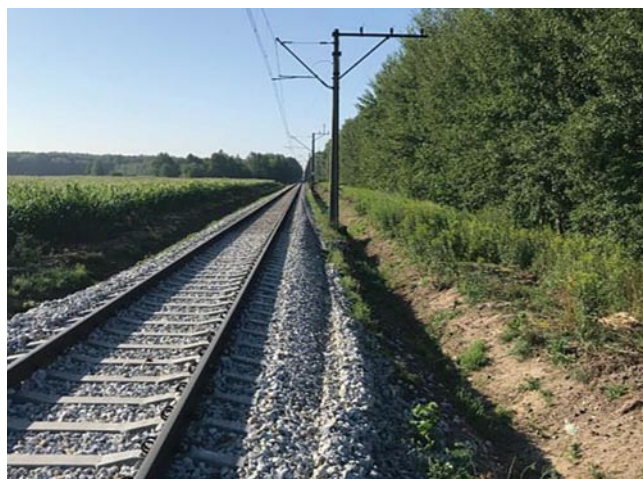
Rys. 3. Usterka pryzmy tłucznia na skutek rolowania szyn
