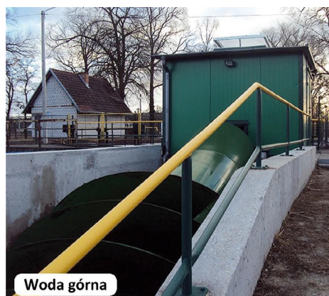
Rys. 7. Stopień wodny Łochowo (turbina Archimedes), Mewat Sp. z o.o. [2, 3]
