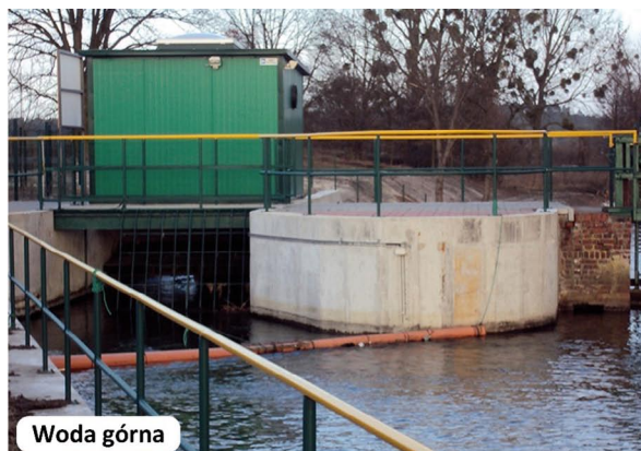
Rys. 8. Stopień wodny Lisi Ogon (turbina Archimedes), Mewat Sp. z o.o. [2, 3]
