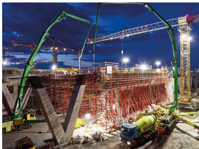
Urządzenie przejezdne skróciło czas budowy platformy jezdnej
