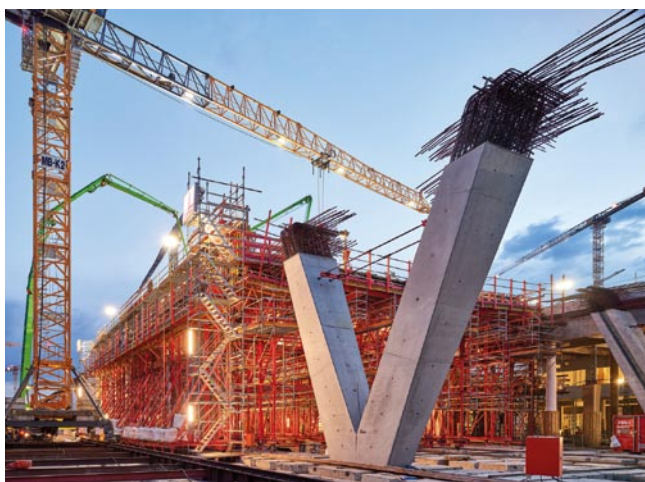
Firma PERI wspomogła budowę platformy jezdnej, dostarczając rozwiązanie w formie urządzenia przejezdnego
