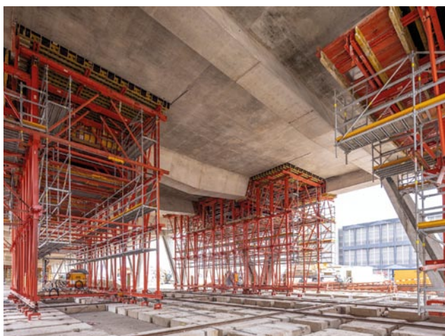
Połączone dwa systemy modułowe VARIOKIT i PERI UP
