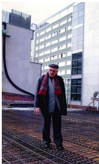
Rozbudowa budynku PASTA
