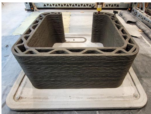
Obiekt demonstracyjny w trakcie procesu wydruku
