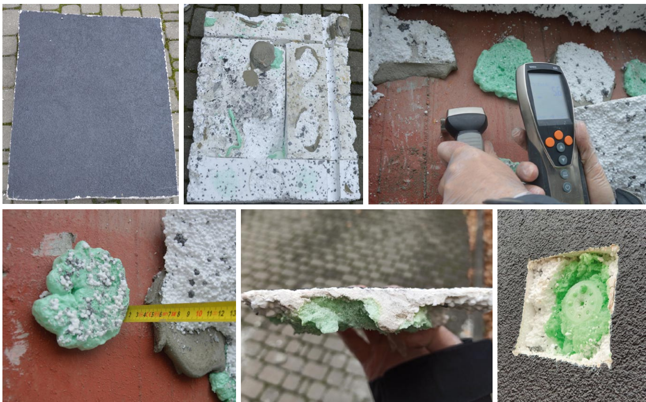
Rys. 2. Widok pobranych próbek i fragmenty obszarów elewacji budynku w miejscach przeprowadzonych odkrywek oraz pomiar wilgotności podłoża [16]
