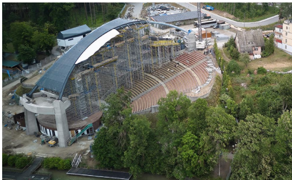
Konstrukcja o kubaturze 18 500 m 3 osiągnęła wysokość 18 m i szerokość 25 m
