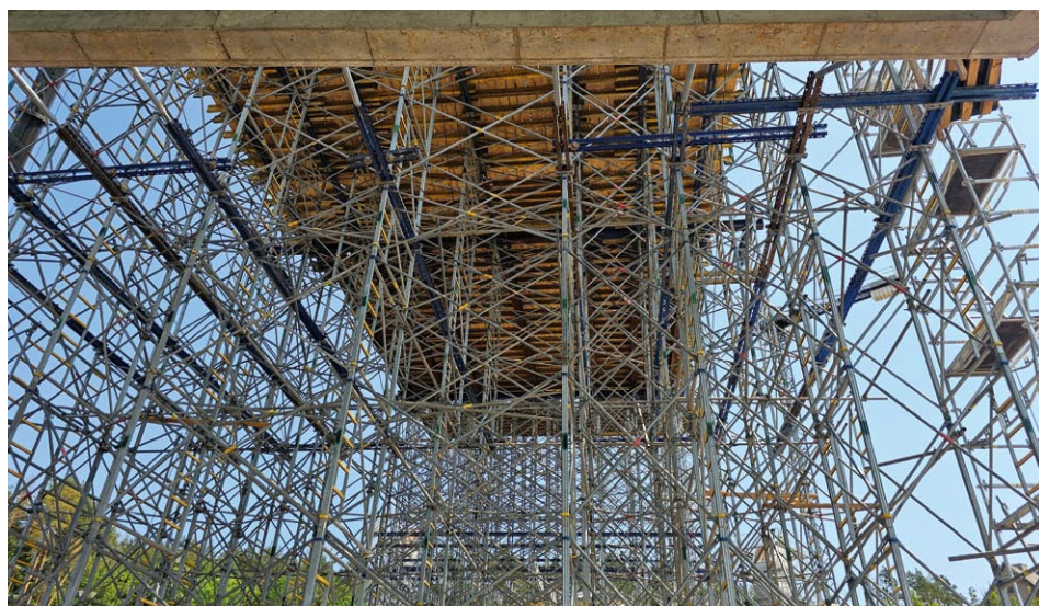
Do budowy konstrukcji nośnej wykorzystano tony materiału Staxo
