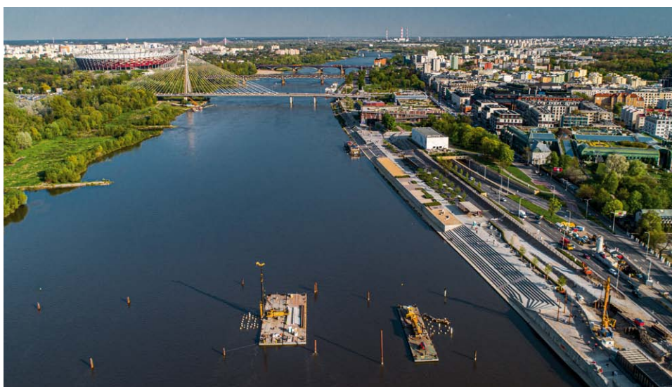
Aarsleff. Budowa Kładki przez Wisłę w Warszawie, rok 2022
