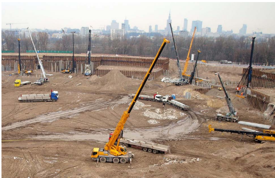
Aarsleff. Budowa Stadionu Narodowego, rok 2009
