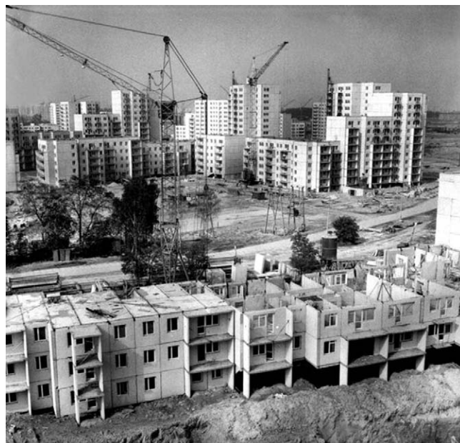
Rys. 1. Budowa wielkopłytkowego osiedla mieszkaniowego w Nowej Hucie w latach 60. XX wieku
